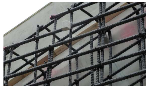
Die Armierungsnetze wurden doppelartig angebracht.
