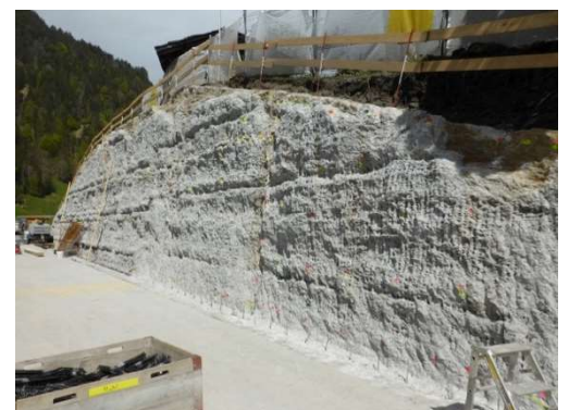
Der sanierungsbedürftige Teil der Mauer und die alten Armierungen wurden entfernt.
