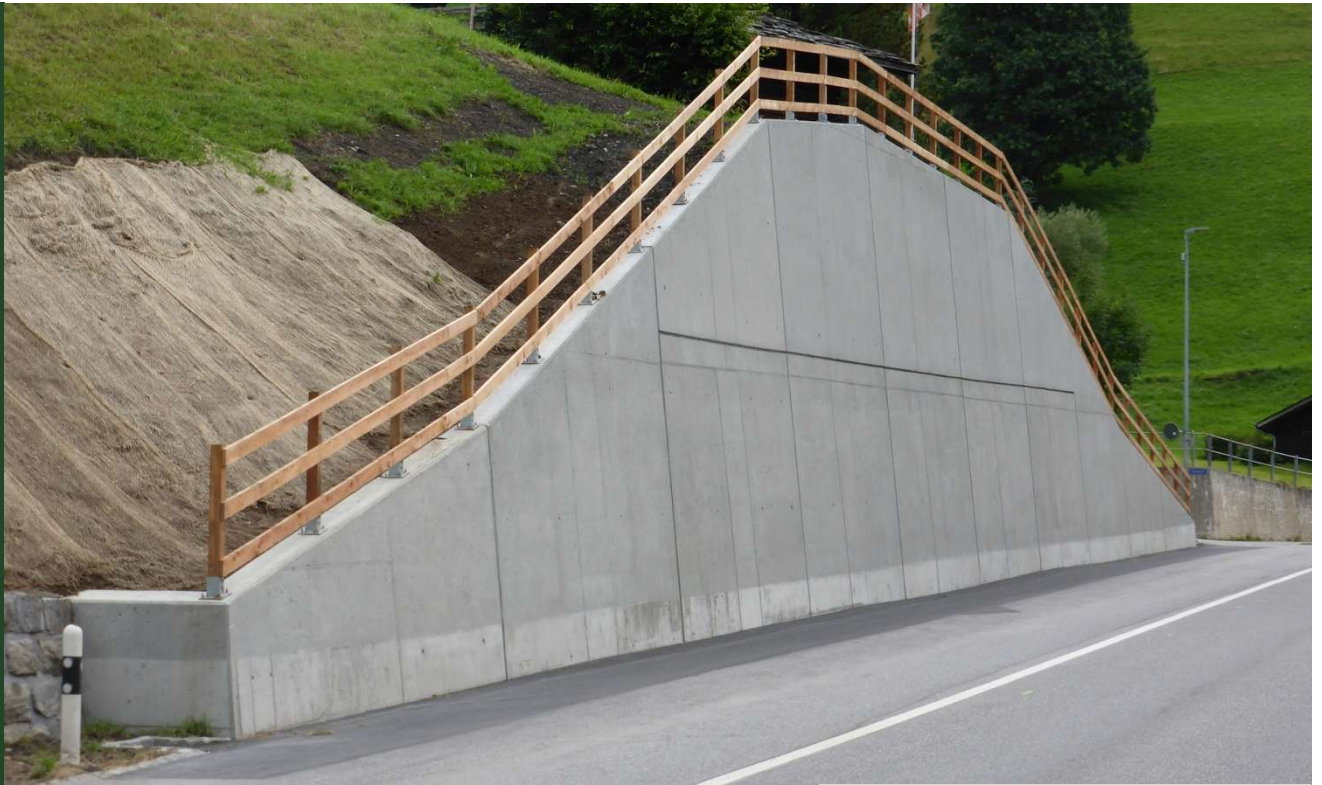
Die sanierte Stützmauer in neuer Frische.
