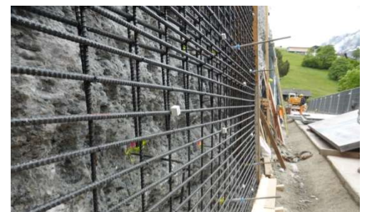
Die verbauten Armierungsnetze
